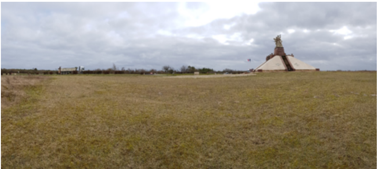
Vue du coin Nord-Ouest de la parcelle, côté tranchées et cratères
